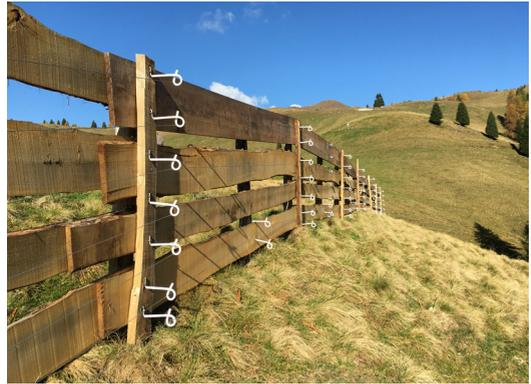
**Foto n. 15** - Foto n. 15 - Recinzione tradizionale in legno con elettrificazione a 7 fili in zinco alluminio sul lato esterno, finanziata nel 2024 per la tutela notturna di ovicaprini in alpeggio (M. Zeni - Archivio Servizio Faunistico PAT)
