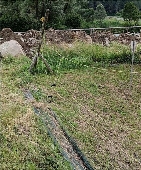
**Figura 1** - Recinzione elettrificata non idonea: anche in presenza di elettrificazione adeguata, la paleria cadente e i conduttori laschi ne pregiudicano irrimediabilmente la funzionalità
